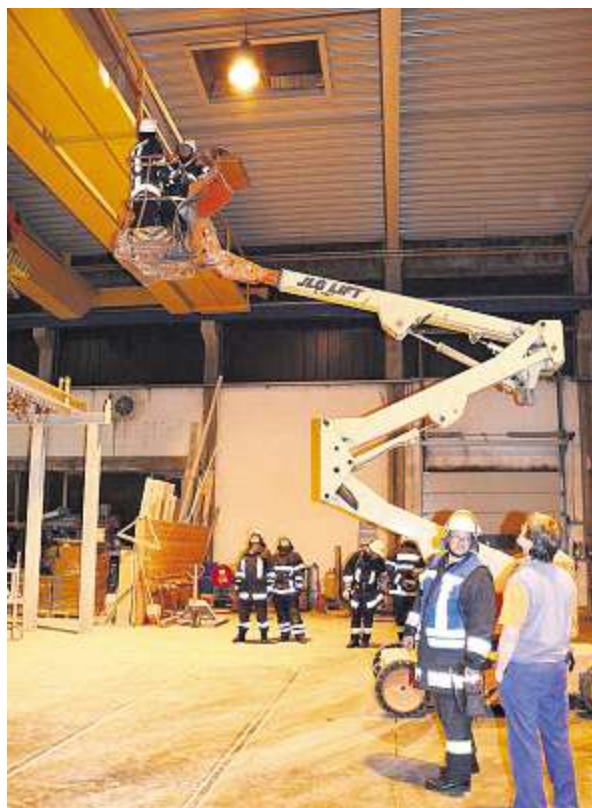
Mittels Teleskop-Hebebühne gelangten die Einsatzkräfte zum Arbeitsbereich auf dem Laufkran.
